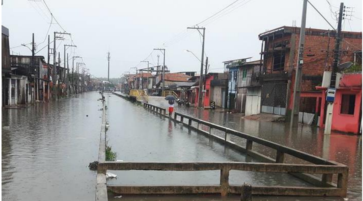
Figura 5 - Transbordamento do canal na Avenida Cipriano Santos no bairro de Canudos (um dos trechos do igarapé Tucunduba) em dia de chuva forte.
