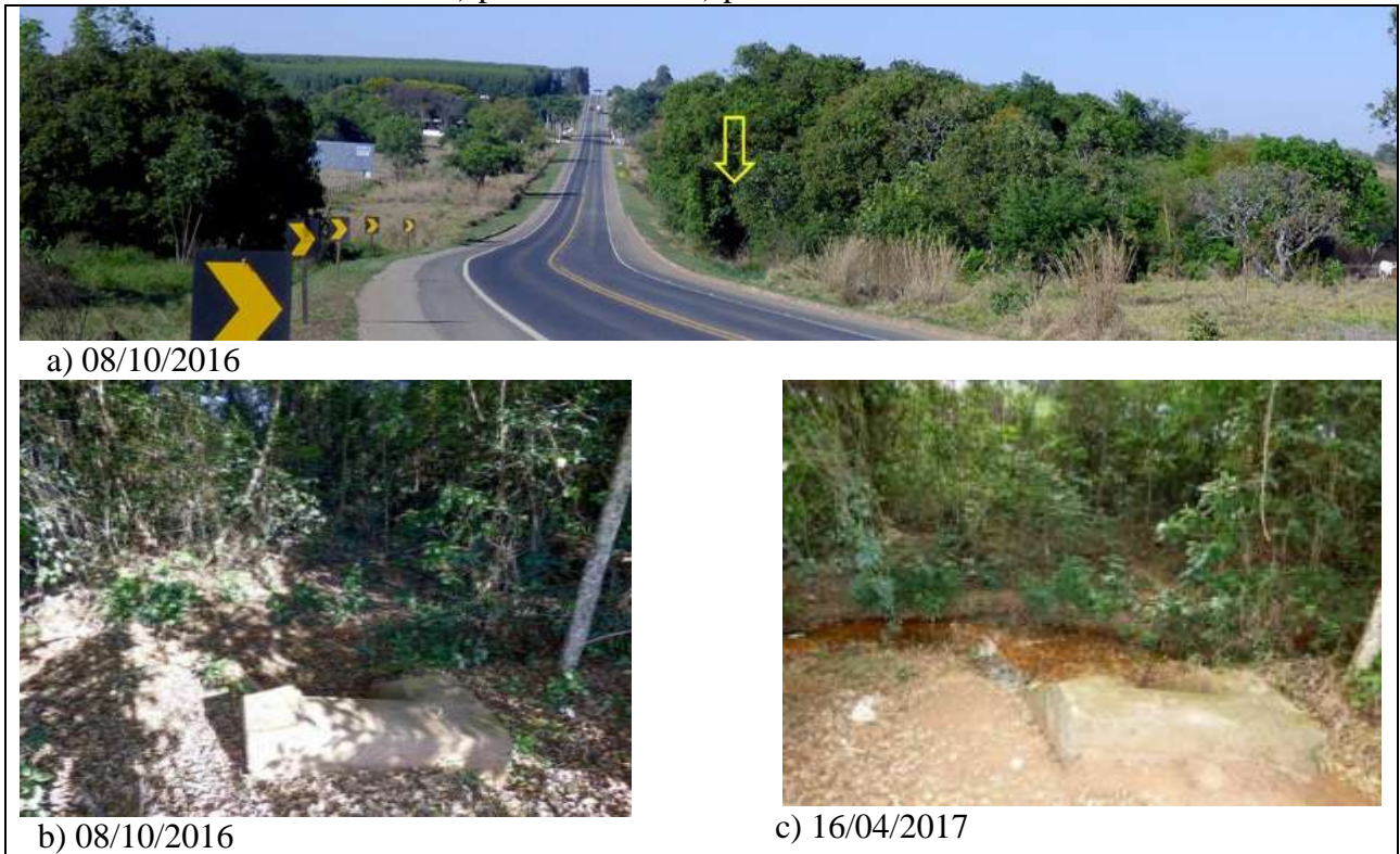
Figura 9 - a) exemplos de conflito de uso em APP, corte estrada e pastagem, a poucos metros da nascente principal do ribeirão Samambaia, BR-050; detalhe indicado pela seta; b) período seco e c) período chuvoso
