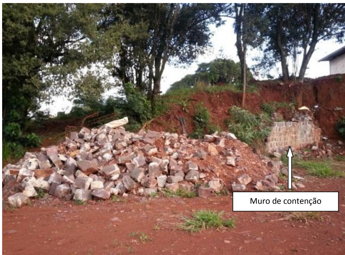
Figura 3: Vestígios do muro de contenção.
