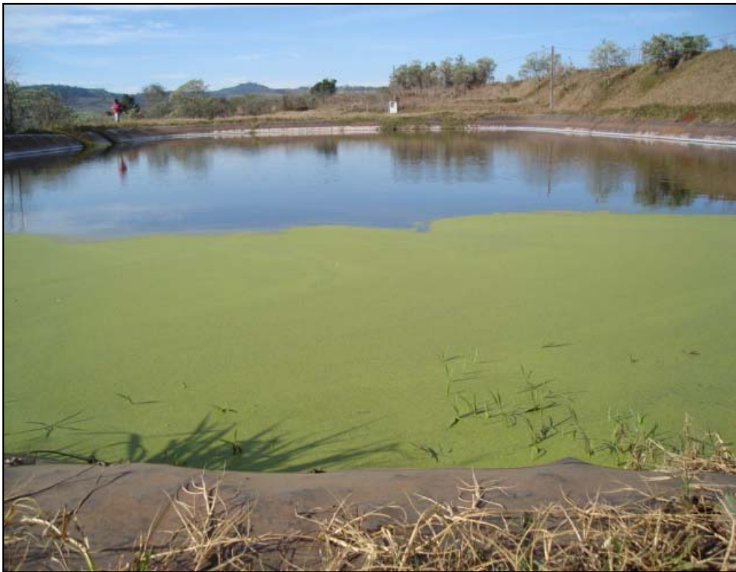
Figura 3 - Lagoa anaeróbia – aterro sanitário de Francisco Beltrão.
