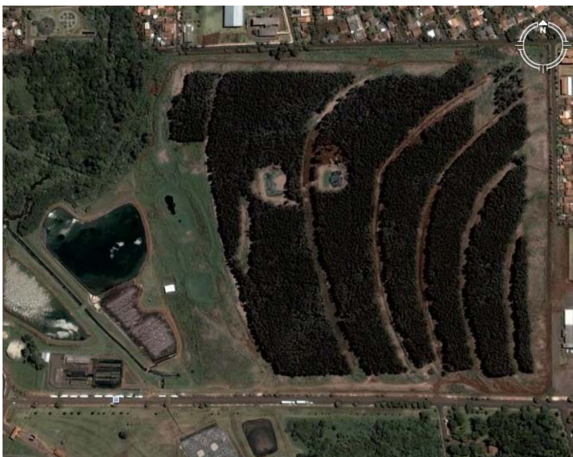
Figura 1 – Sistema de tratamento de efluentes da unidade frigorífica avaliada.
