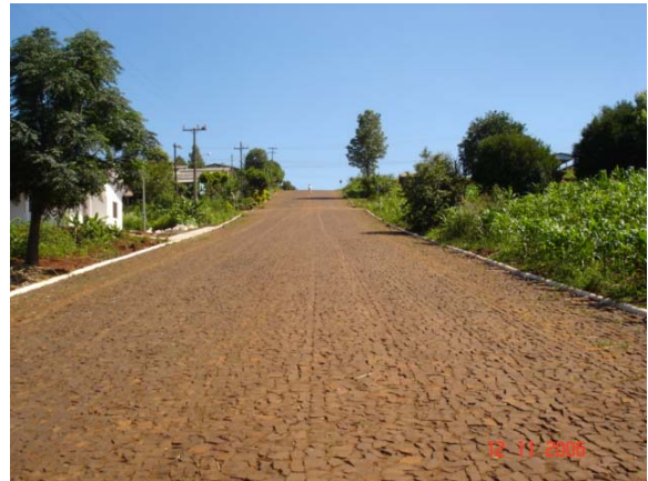
Figura 6: Rua Atanásio Pires – 13 m largura.
