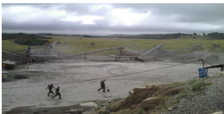
Figura 6 – Usina de Britagem
