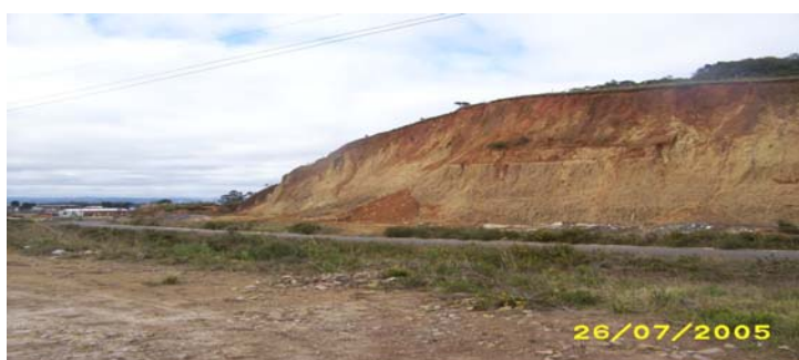
Figura 2 – Caixa de empréstimo de saibro – estaca 55 (LD)
