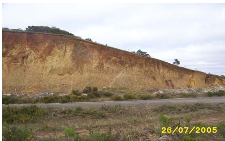
Figura 12 – Talude existente na estaca 55
