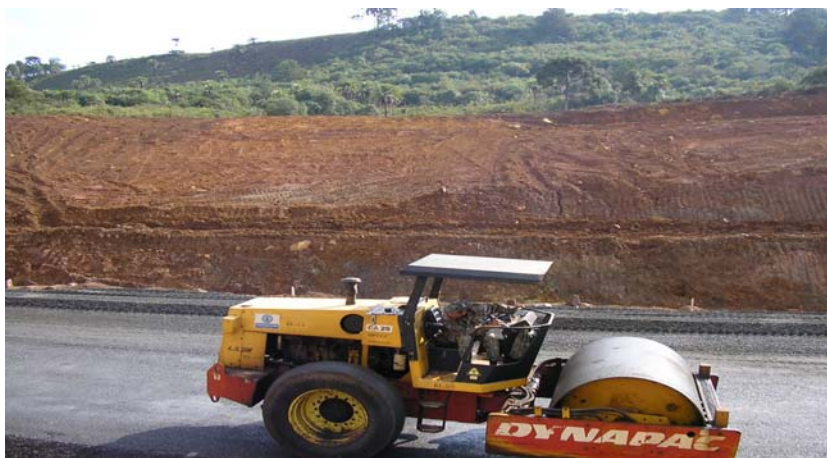
Figura 11 – Talude de corte com material de 1ª categoria descoberto
